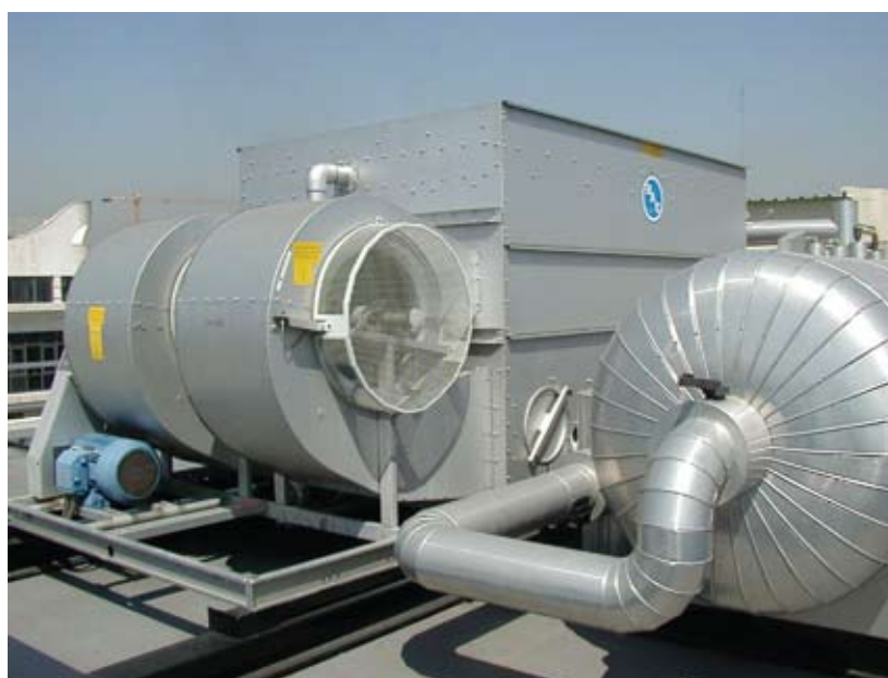
Figura 3: Condensador evaporativo
